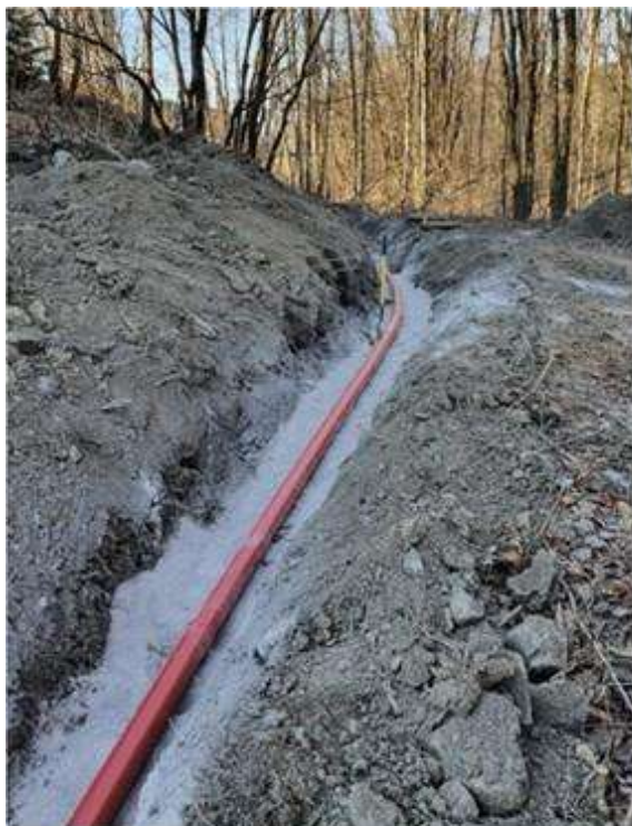
Figur 9a: Grøft med el-anlegg.
