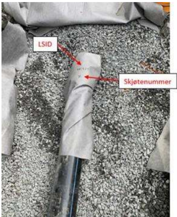
Figur 8: Skjøt i beskyttelsesdukk
