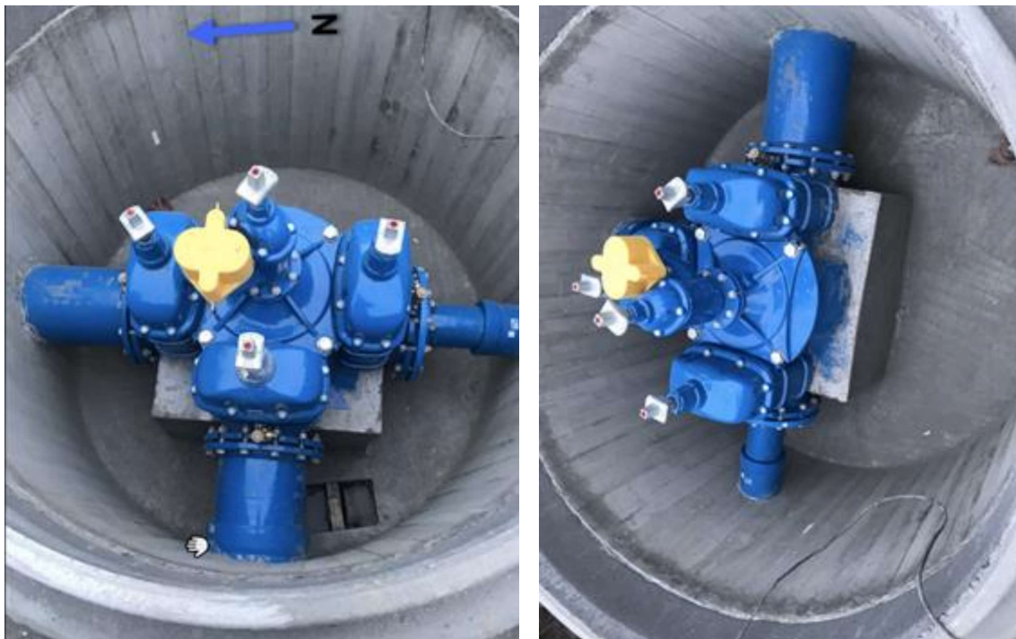
Figur 4: Kumbilder som viser innhold i kum før betongsøylen bygges.
