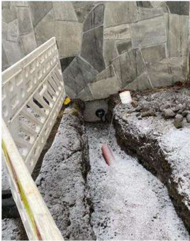
Figur 9c: Påkoblingspunkt.
