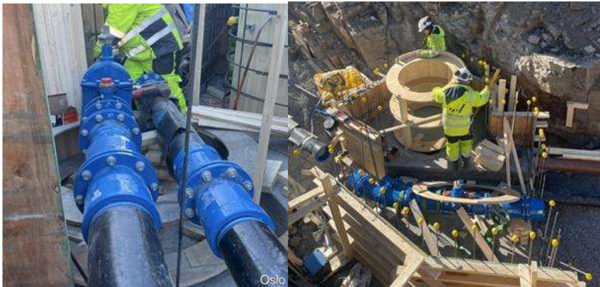
Figur 2: Kumbilder før støp av bunnseksjon.
