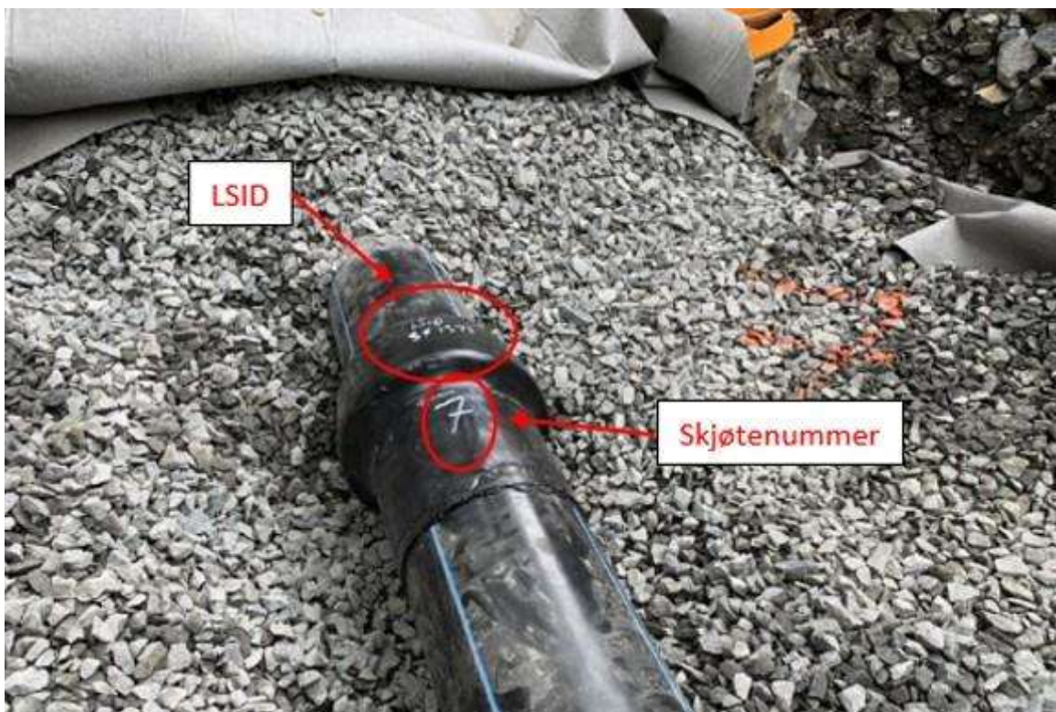
Figur 7: Rør med montert krympemuffe.
