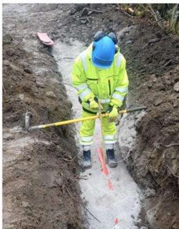
Figur 9b: Dybdemål.
