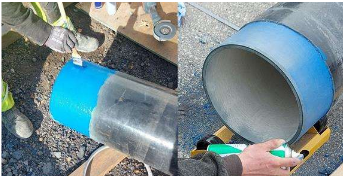
Figur 6: Rør etter påføring av zinkspray og epoxymaling.
